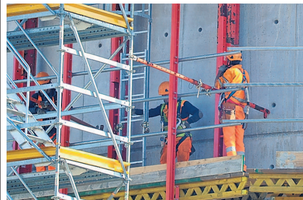
▲ La storia L'inaugurazione del Morandi del 1967 e, sotto, il cantiere del nuovo ponte
